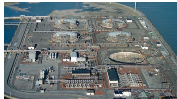
Zeebrugge LNG Terminal, Bélgica
